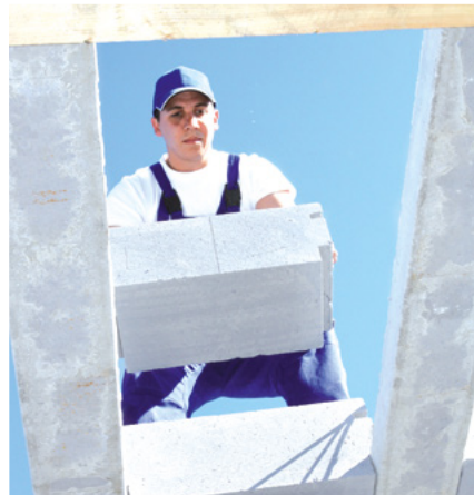
Ukladanie stropných vložiek
