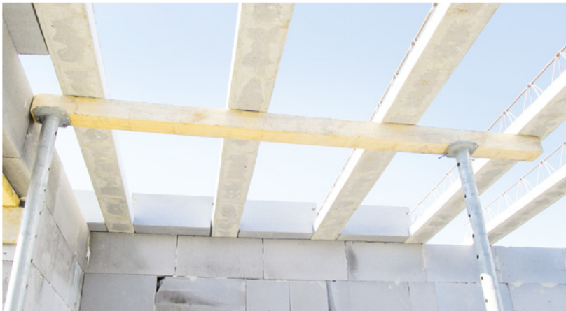
Podopretie stropných nosníkov
